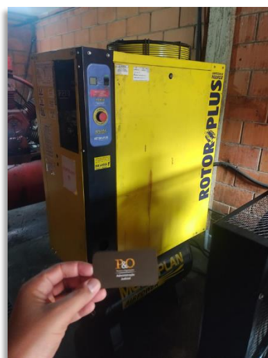
Foto 12: Casa de máquinas, onde fica os compressores de Ar para atender a linha de produção
