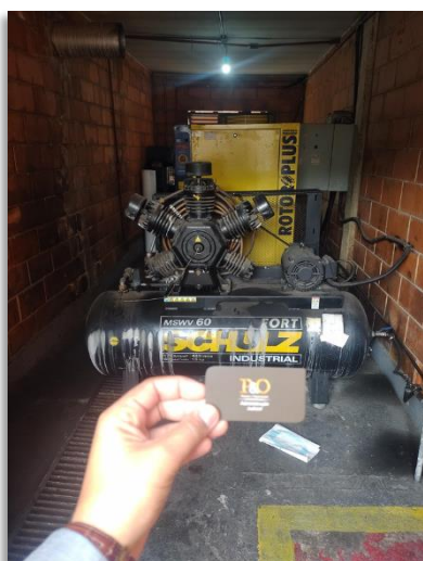
Foto 12: Casa de máquinas, onde fica os compressores de Ar para atender a linha de produção
